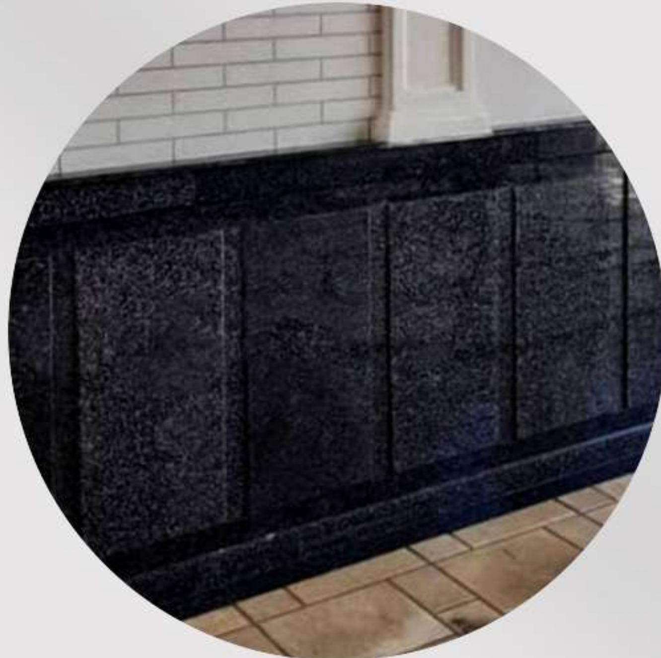
گرانیت مشکی پیرانشهر مقاوم ترین سنگ های می باشد. از ویژگی های این سنگ مقاومت فشاری و سایشی بالا و جذب آب پایین است که از این گرانیت در مکان های پرتردد مانند سنگ فرش خیابان ها، ساختمان های اداری و تجاری، ایستگاه های مترو و ... میتوان استفاده کرد.
